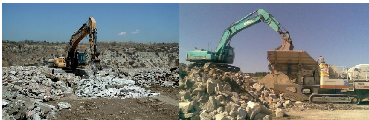
Figura 8: Foto ilustruese e makinerisë gurëthyese
